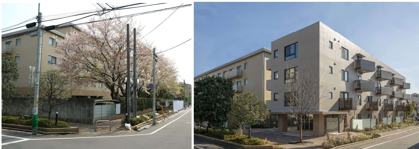
北西外観（左から、施工前、施工後）
